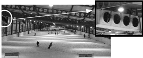
La température dans le bâtiment est contrôlée par des frigorifères qui sont des dispositifs de ventilation et de refroidissement de l'air (figure ci-dessus). Chaque frigorifère est muni d'une sonde de température ambiante Pt100 et d'un dispositif de régulation :
